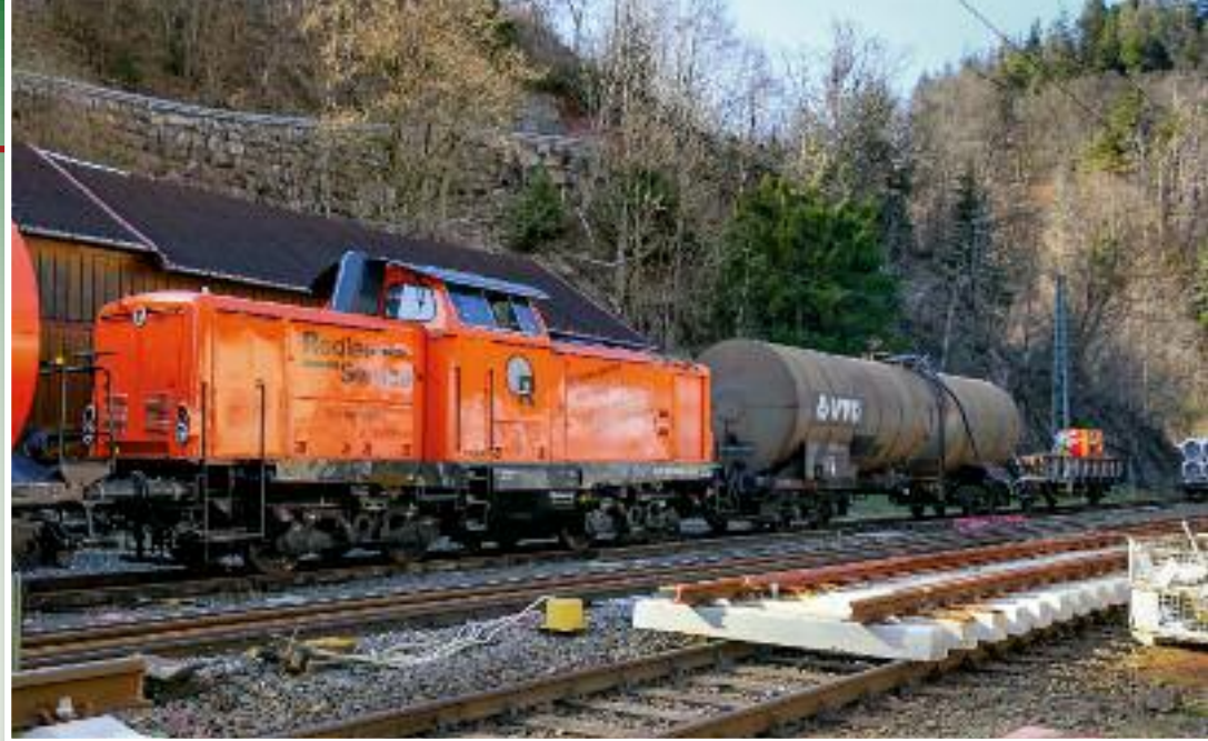
Für Brandfälle während der Bauarbeiten steht im Bahnhof Triberg ein Kesselwagen der VTG mit Löschwasser bereit.
